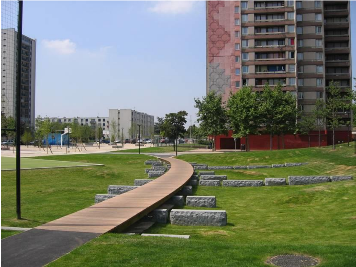
Infiltration basin - France Santiago du Chili – Aqua y Ciudad
