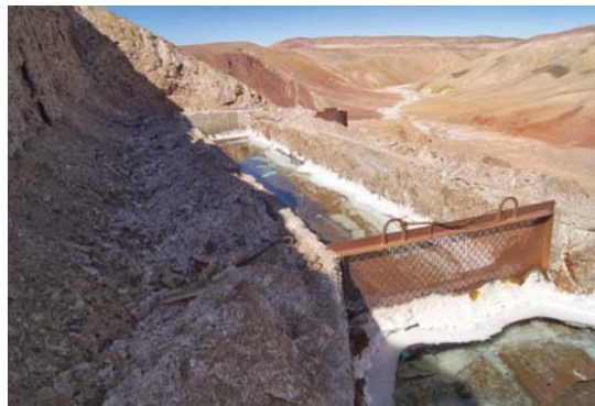
Imagen 6. Canalización del Salar de Pedernales que drena agua salina hacia el río El Salado o de la Sal, terreno Atacama Marzo 2014 (por Andrés Villagrán).
