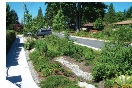
Imagen 2. Celda de infiltración en la calle 2nd Avenue NW de la ciudad de Seattle, EE.UU. (NACTO, 2017).
