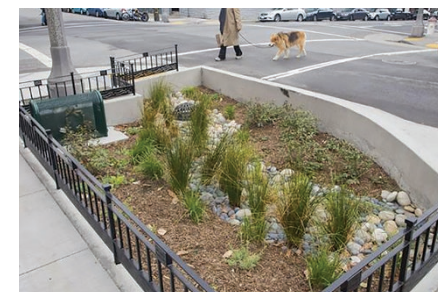
Imagen 1. Celda de bioretención en la calle Fell Street de la ciudad de San Francisco, EE.UU. (NACTO, 2017).
