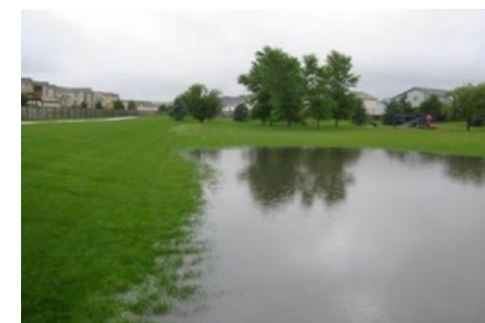
Imagen 3. Estanque de retención como área verde en proceso de llenado durante una tormenta en la ciudad de Fort Collins, EE. UU. (DOH, 2013).
