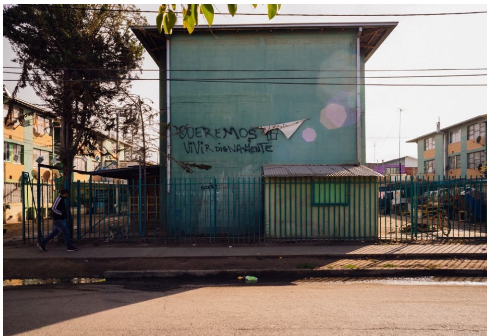
Imagen 1: Viviendas sociales, Calle Quitalmahue.
