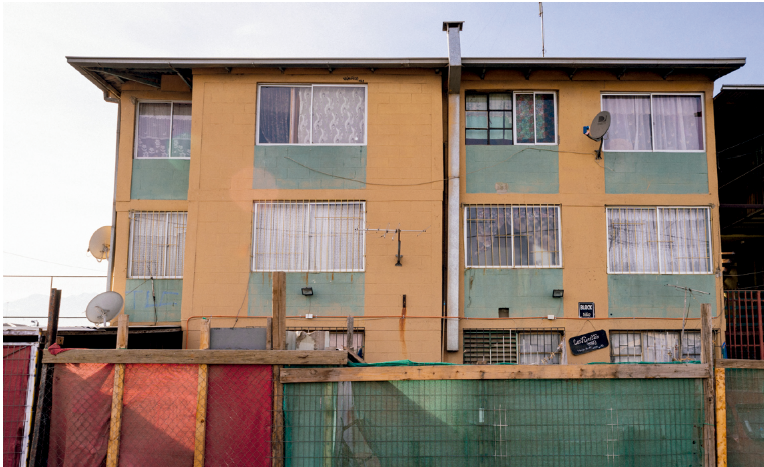
Bajos de Mena, Puente Alto. Fuente: Archivo CEDEUS.
