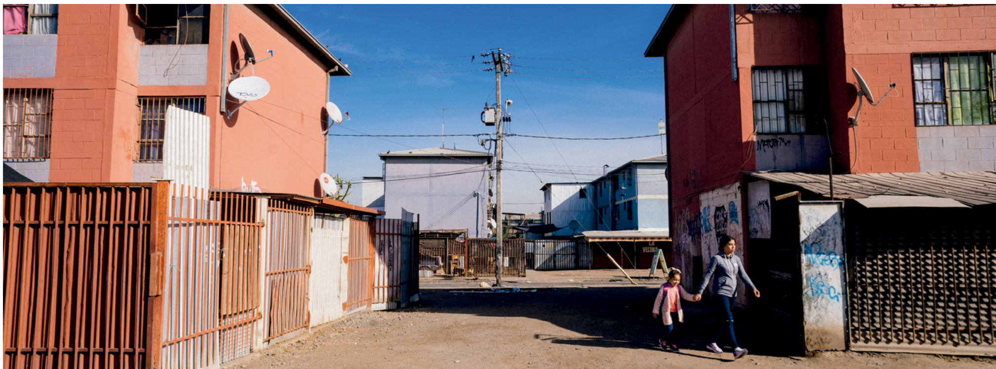
Bajos de Mena, Puente Alto. Fuente: Archivo CEDEUS.
