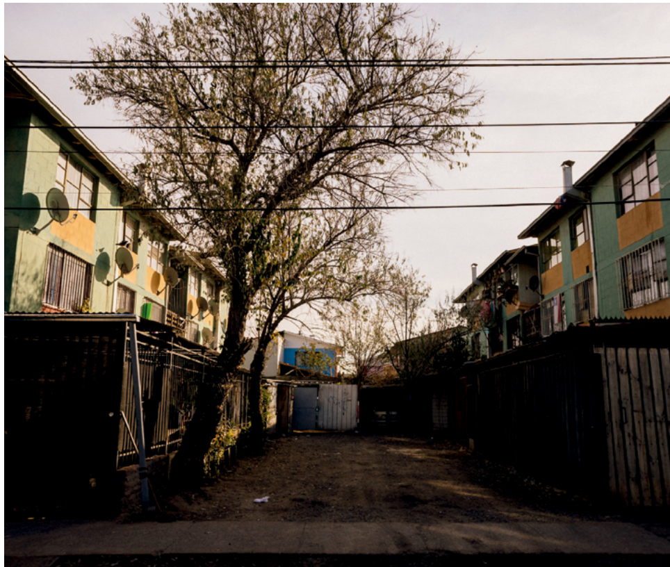
Bajos de Mena, Puente Alto. Fuente: Archivo CEDEUS.
