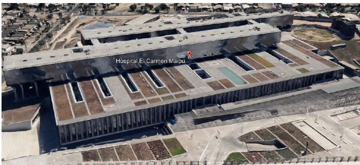
Figura 3.6. Situación techo vegetativo Hospital El Carmen de Maipú en enero de 2019.
