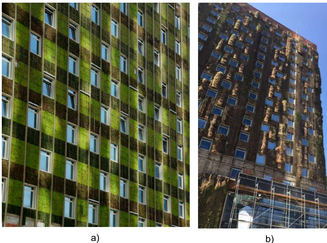
Figura 3.5. Situación muro vegetativo Hotel InterContinental. a) Condición original año 2011-2012 (Fuente: adaptado de www.abwb.cl ). b) Condición abril de 2019.
