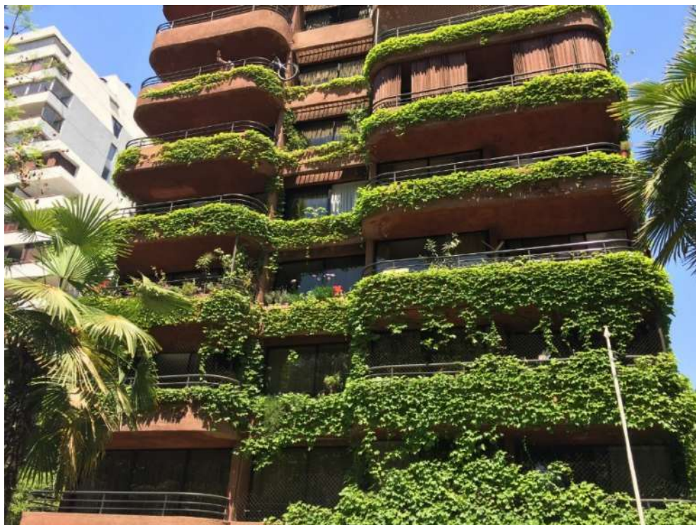
Figura 1.10. Ejemplo muro vegetativo con plantas colgantes: Edificio Residencial, Providencia, Santiago, Chile.
