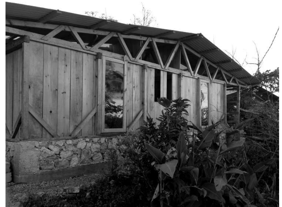
Fig. 2. Proceso de construcción participativa de las casas para las parteras indígenas de Chiapas, México. Fuente: Juan Pablo Rodríguez Méndez, junio de 2017
