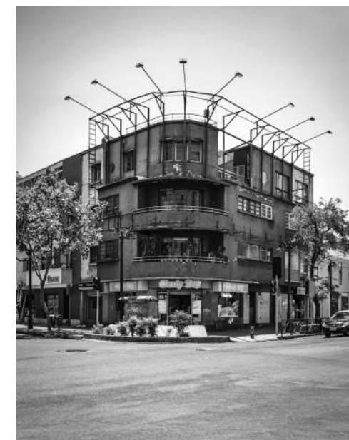
FIG. 4. Edificio Obispo Donoso 032. Arquitecto: José Dvovresky. © Philippe Blanc, 2018
