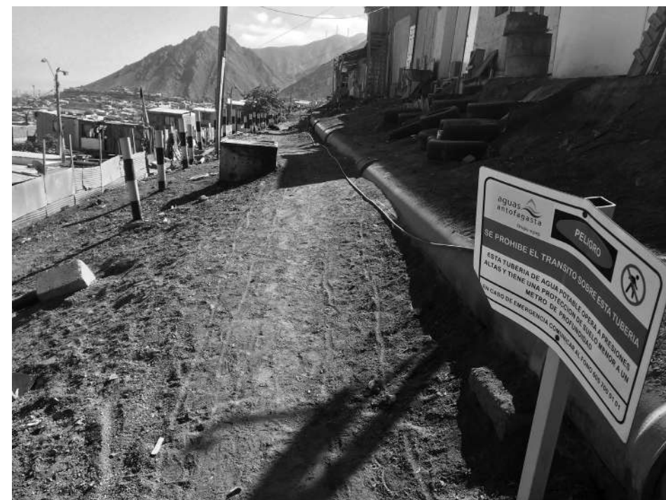
Fig. 4. Zona de riesgo a causa de vivir sobre la franja de servidumbre de la infraestructura sanitaria (Bayer, 2018).
