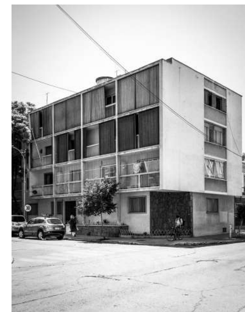
FIG. 2. Edificio Bellavista 014, 1940. Arquitecto: Osvaldo Castillo Vial. © Philippe Blanc, 2018
