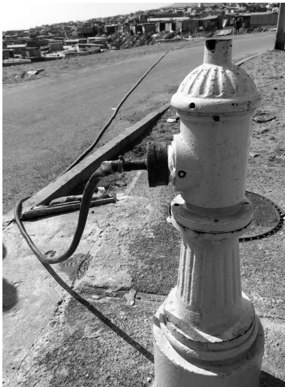
Fig. 3. Conexión a un hidrante en la población, canalizando agua con una manguera hacia el campamento (Bayer, 2018).
