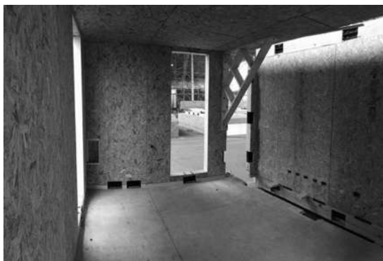
Fig. 2. Módulos sin revestir con elemento arriostrante temporal (Peñaloza, 2018).
