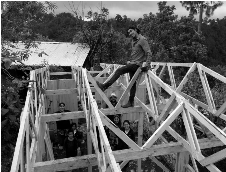
Fig. 1. Proceso de construcción participativa de las casas para las parteras indígenas de Chiapas, México. Fuente: Juan Pablo Rodríguez Méndez, junio de 2017
