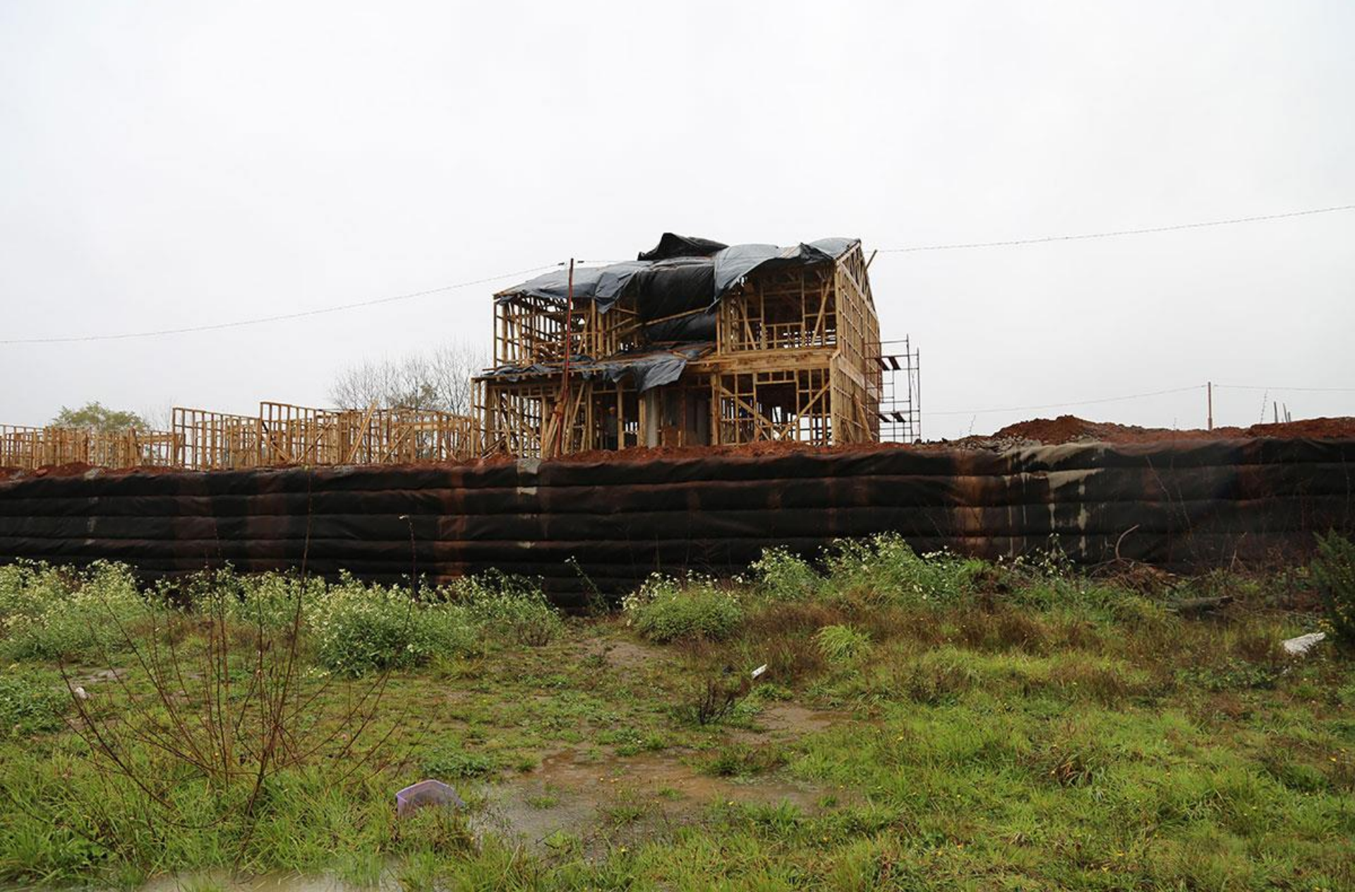
Urbanización sobre relleno de humedales. Construcción de viviendas sociales Nueva Luz - Valdivia. Carolina Rojas
