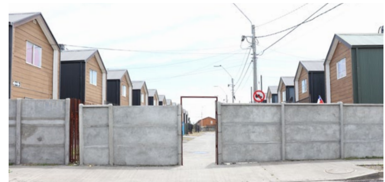
Figura 7: Vista de cierre de pasaje Calle A que une SPDLC 1 con la Población Huertos de la Costa. Fuente: Registro propio.
