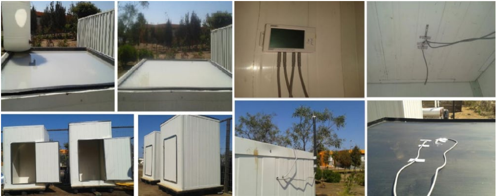
Figura 2. Instalación de las casetas y sensores de temperatura. Fuente: Elaboración propia.
